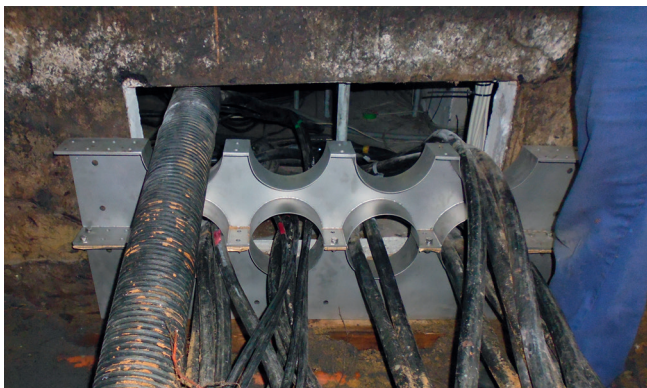
Mise en place des plaques à bride prémontées et désignation des positions de montage avant le passage mural.
