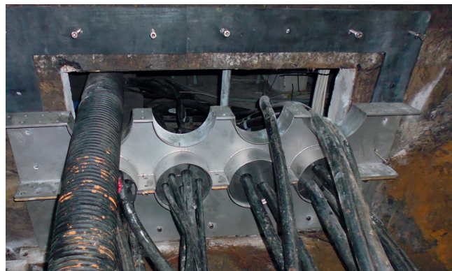
Joint plat collé au mur avec le produit d'étanchéité Sikaflex.
