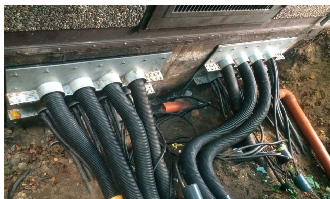
État final après mise en place des brides et inserts d'étanchéité avant fermeture de la tranchée.
